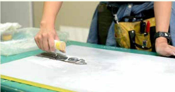
砂岩風のボードが乾くまで、折戸さん指導の下、2つ目の作品に取り掛かります。ベースにグレーを塗ったボードを使い、アレスシックイのグレーをごく薄く水で伸ばしてコテで塗り、モルタル壁風に仕上げしていきます。
